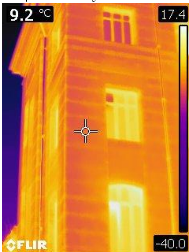
Figura 2.2 – Immagine termografica facciata - serramenti
